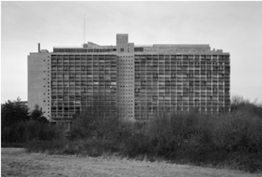
Le Corbusier, Unité d'Habitation, Firminy, begun 1965
